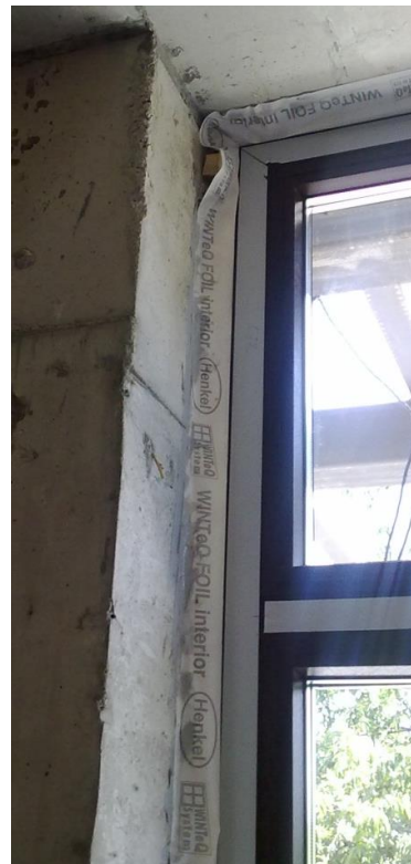
Монтаж на прозорци
