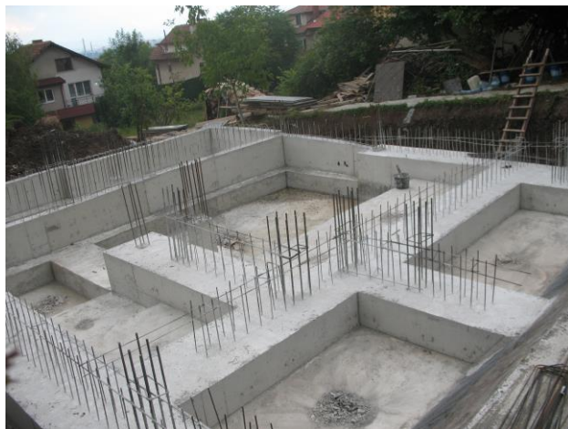
Основи преди полагане на топлоизолация
