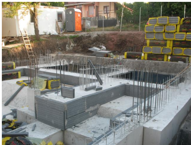
Основи след полагане на топлоизолация
